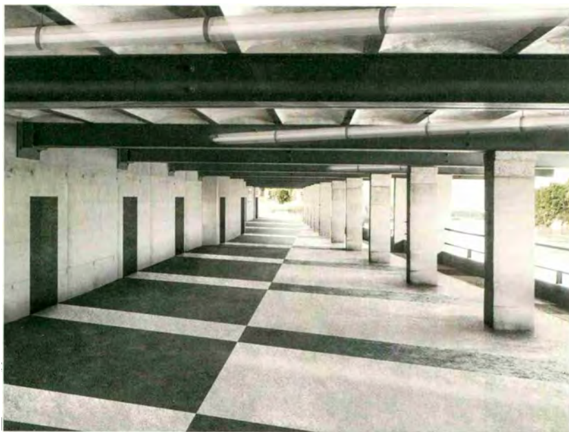
Schneider Türtscher Architekten planen bei ihrem Projekt «Forelle» eine künstliche Licht und Schattenapplikation auf Wand und Boden.
