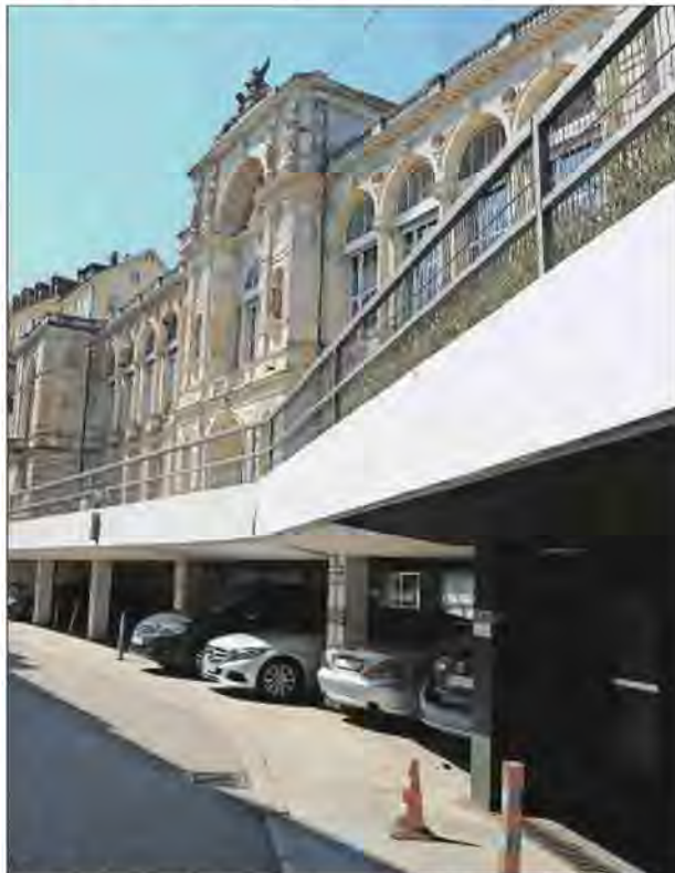
Heute erinnert der Bereich an eine Parkgarage. Das historische Bad rückt in den Hintergrund.
