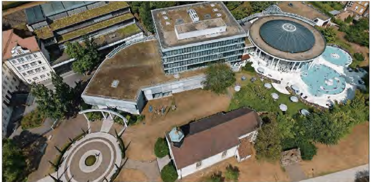
Anno 1984: Die Caracalla-Therme ist nach 36 Jahren sanierungsbedürftig.
