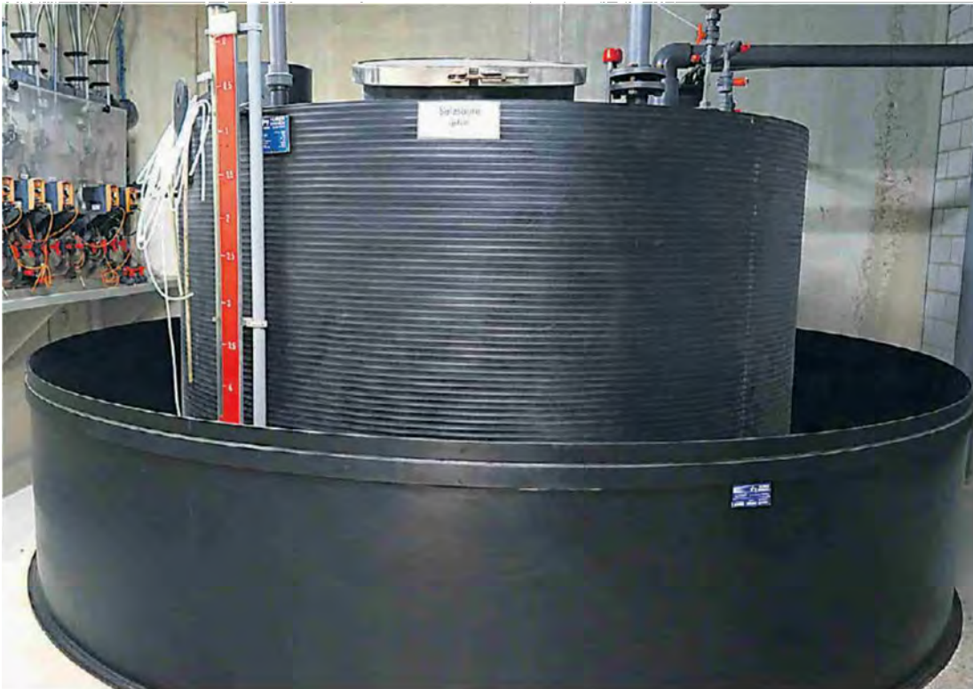
Der Salzsäuretank reicht für rund zwei Monate, um den PH-Wert zu regulieren.
