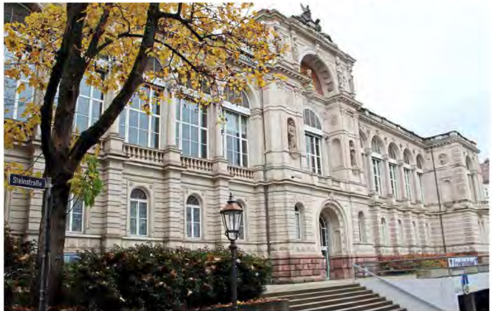
Ein Wahrzeichen der Kur- und Bäderstadt: Vor allem für dringende Sanierungsarbeiten im Friedrichsbad sollen die zusätzlichen Mittel von 2,8 Millionen Euro verwendet werden, die das Land in den Etatentwurf 2022 aufgenommen hat. Foto: Ralf Joachim Kraft
