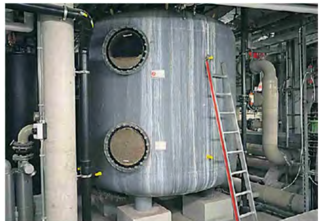
Die ältesten Mehrschichtfilterbecken sind noch nicht quadratisch.
