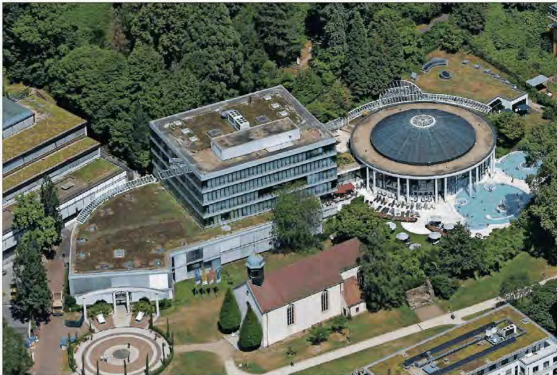
Die Zeichen stehen auf Grün: Die groß angelegte Sanierung soll das Gesicht der Therme verändern.
