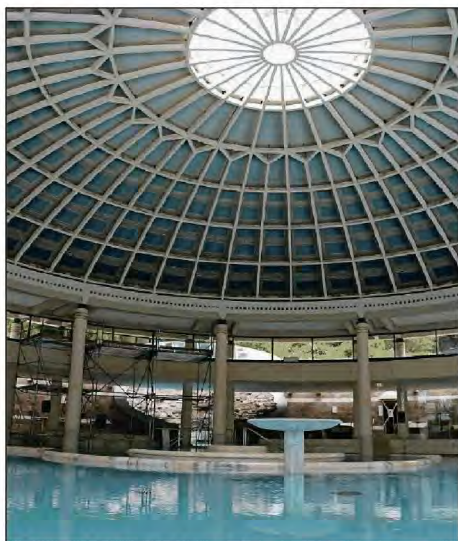
Im Innenbereich sind die Becken schon gefüllt. Auch das Gerüst im Hintergrund wird noch verschwinden. Fotos: Reith
